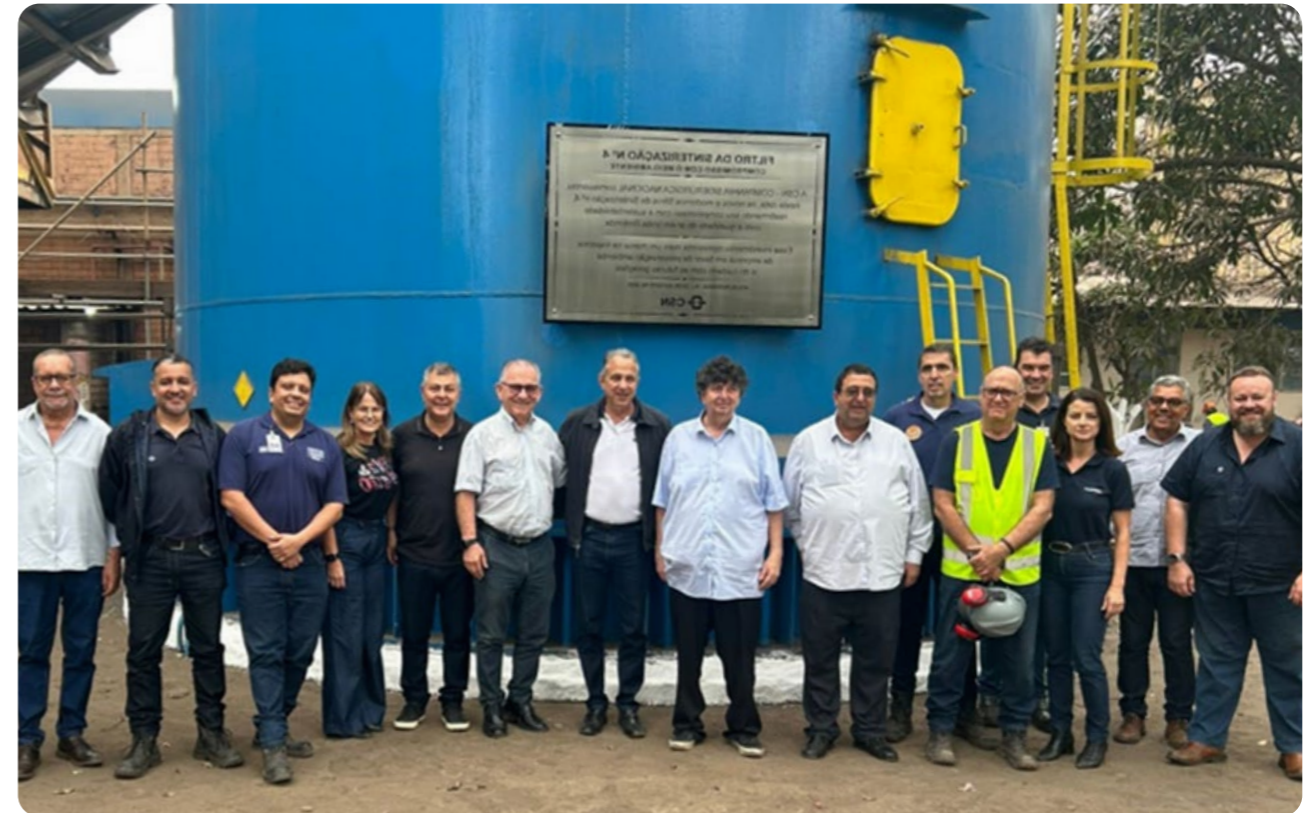
→ Inauguração do novo conjunto de controles ambientais nas sinterizações - Volta Redonda (RJ)
