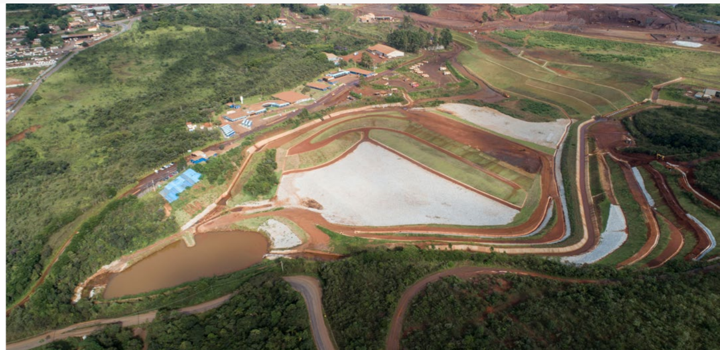
→ Barragens Vigia e Auxiliar do Vigia, já descaracterizadas - Ouro Preto (MG)
