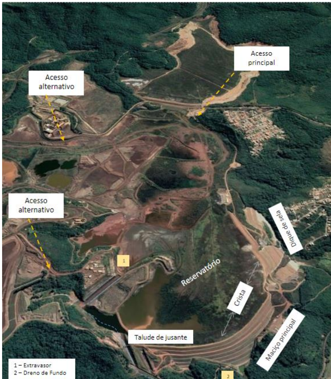
Figura 4-1 - Vista da Barragem Casa de Pedra e suas características
