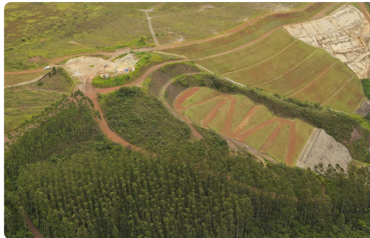
→ The Casa de Pedra dam - Congonhas (MG)
