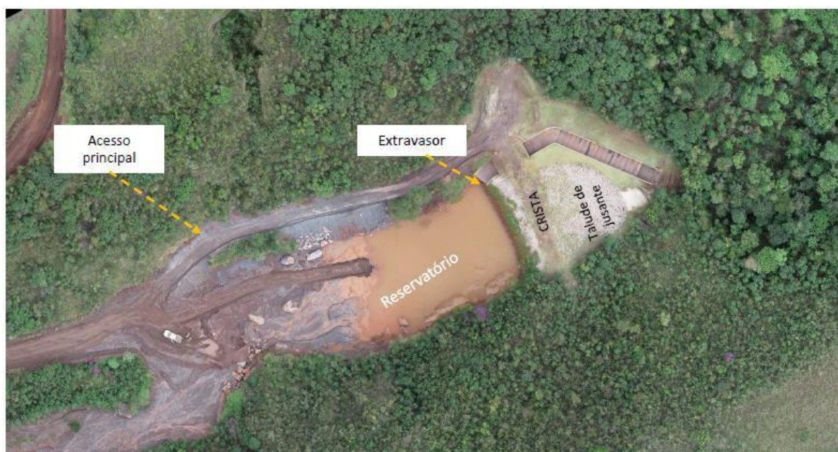
Figura 4-1 – Vista do Dique do Engenho
