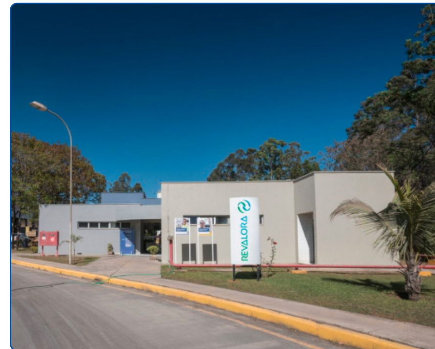
→ Escritório administrativo da Revalora – Pedro Leopoldo (MG)
