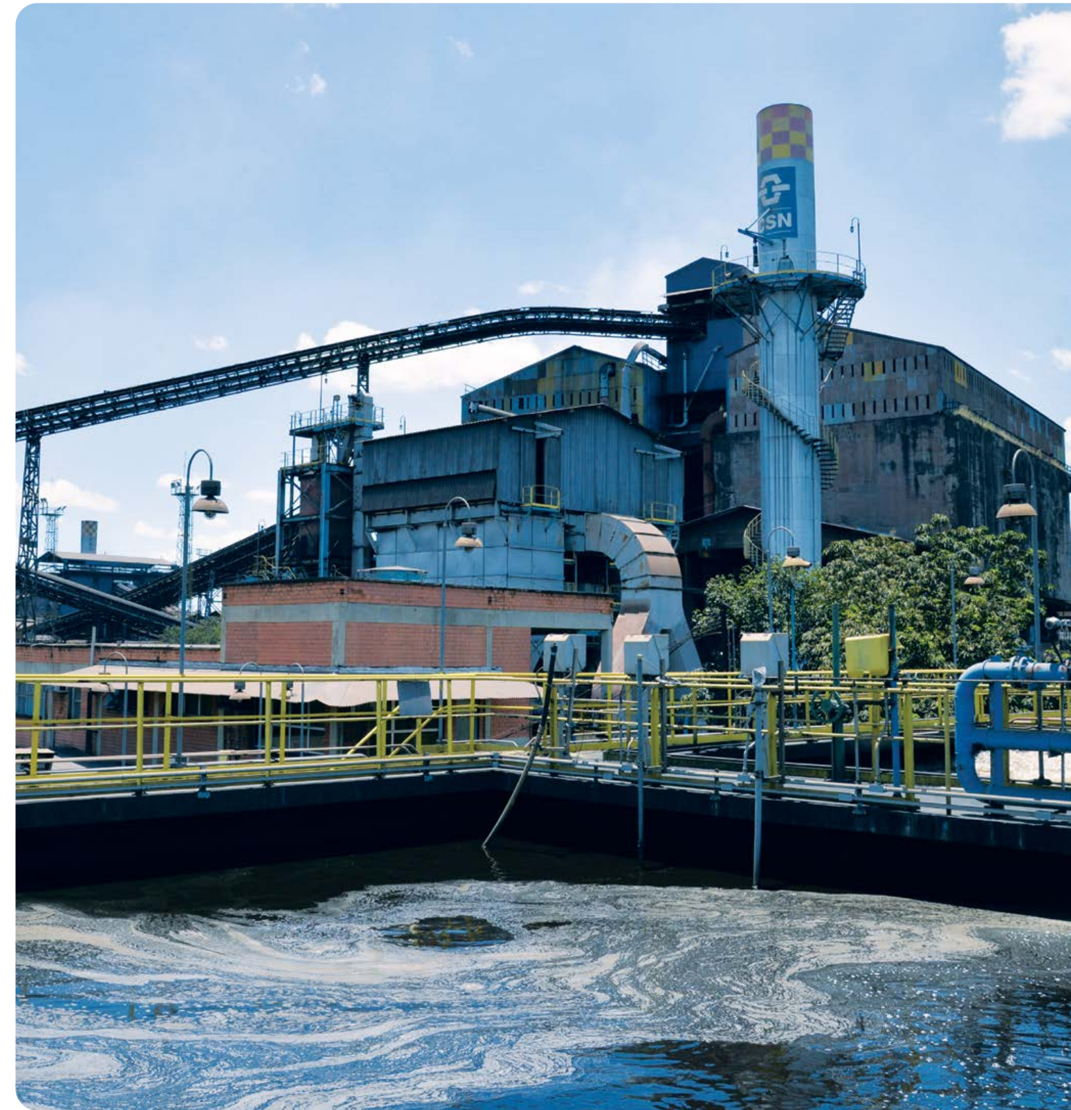
Estação de Tratamento de Água na Usina Presidente Vargas
