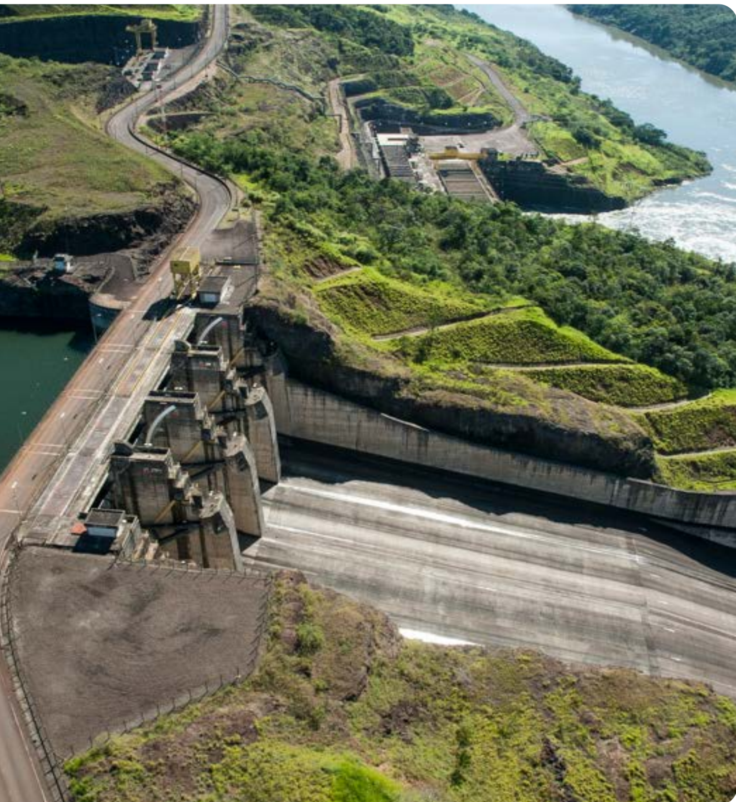
Hidrelétrica de Itá (SC)
