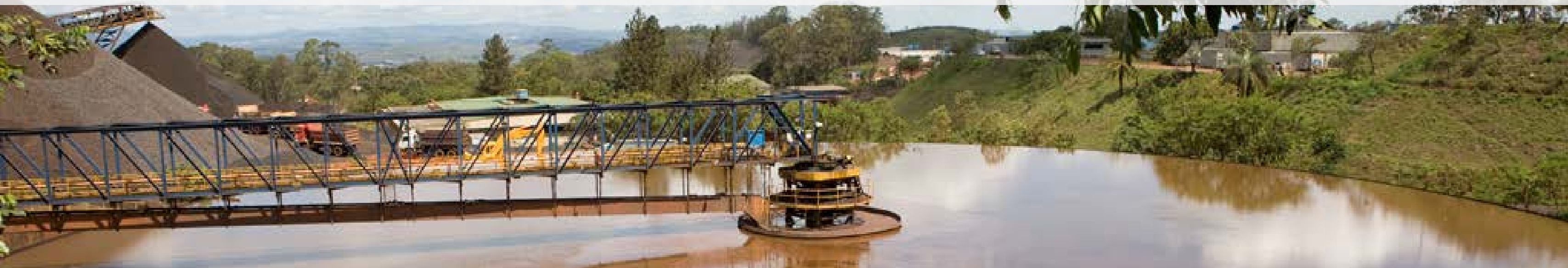
Espessador de rejeitos
