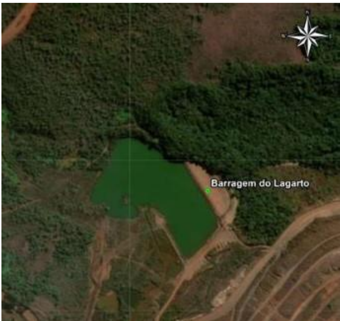
Figura 2 - Vista da Barragem do Lagarto.
