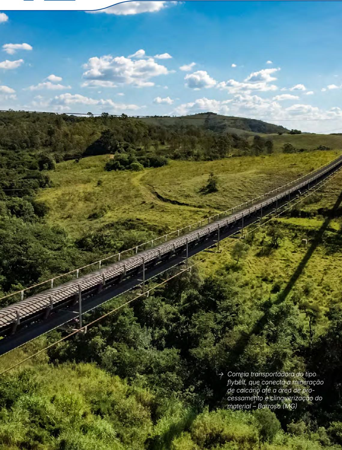
→ Correia transportadora do tipo flybelt, que conecta a mineração de calcário até a área de processamento e clinkerização do material – Barroso (MG)
