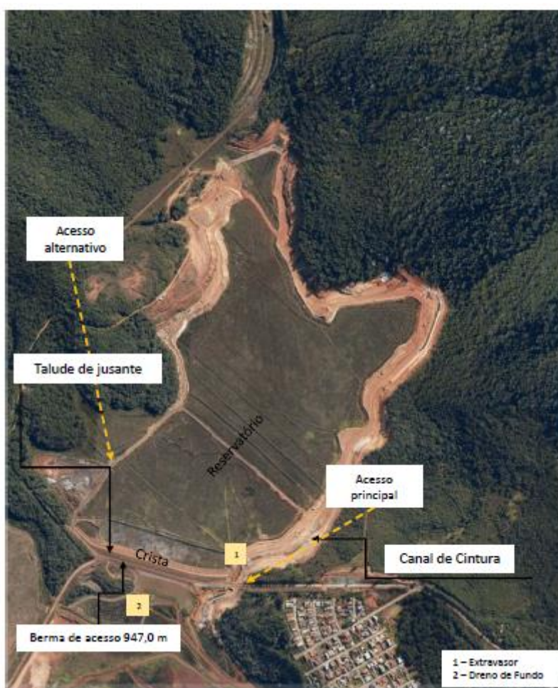
Figura 4-1 – Vista da Barragem B4.
