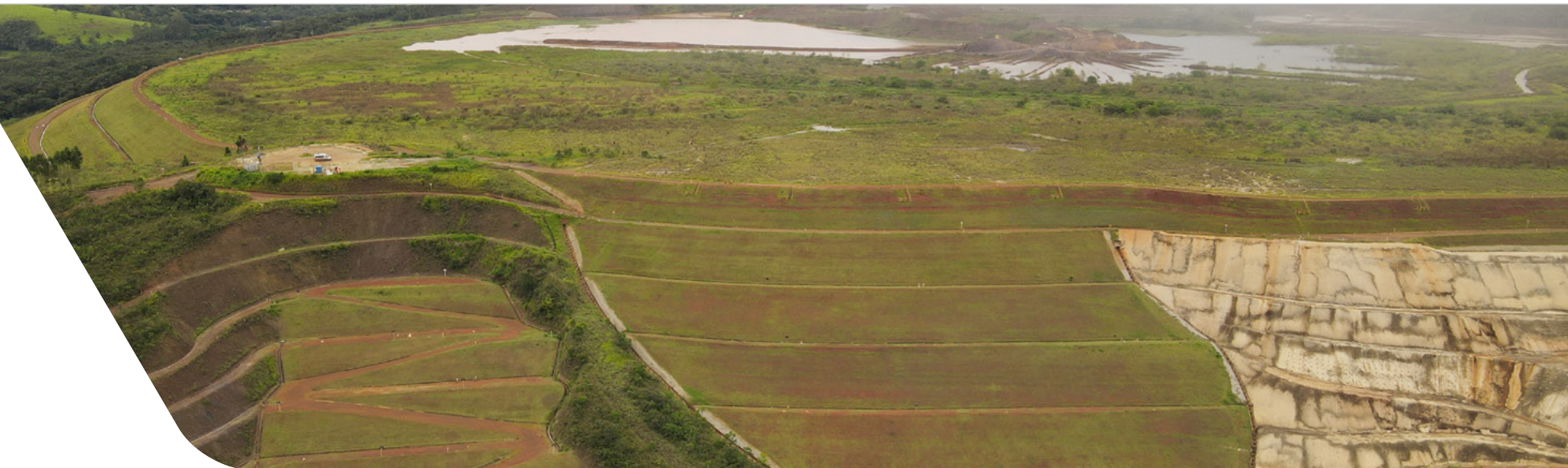
Barragem Casa de Pedra (Congonhas, MG)
