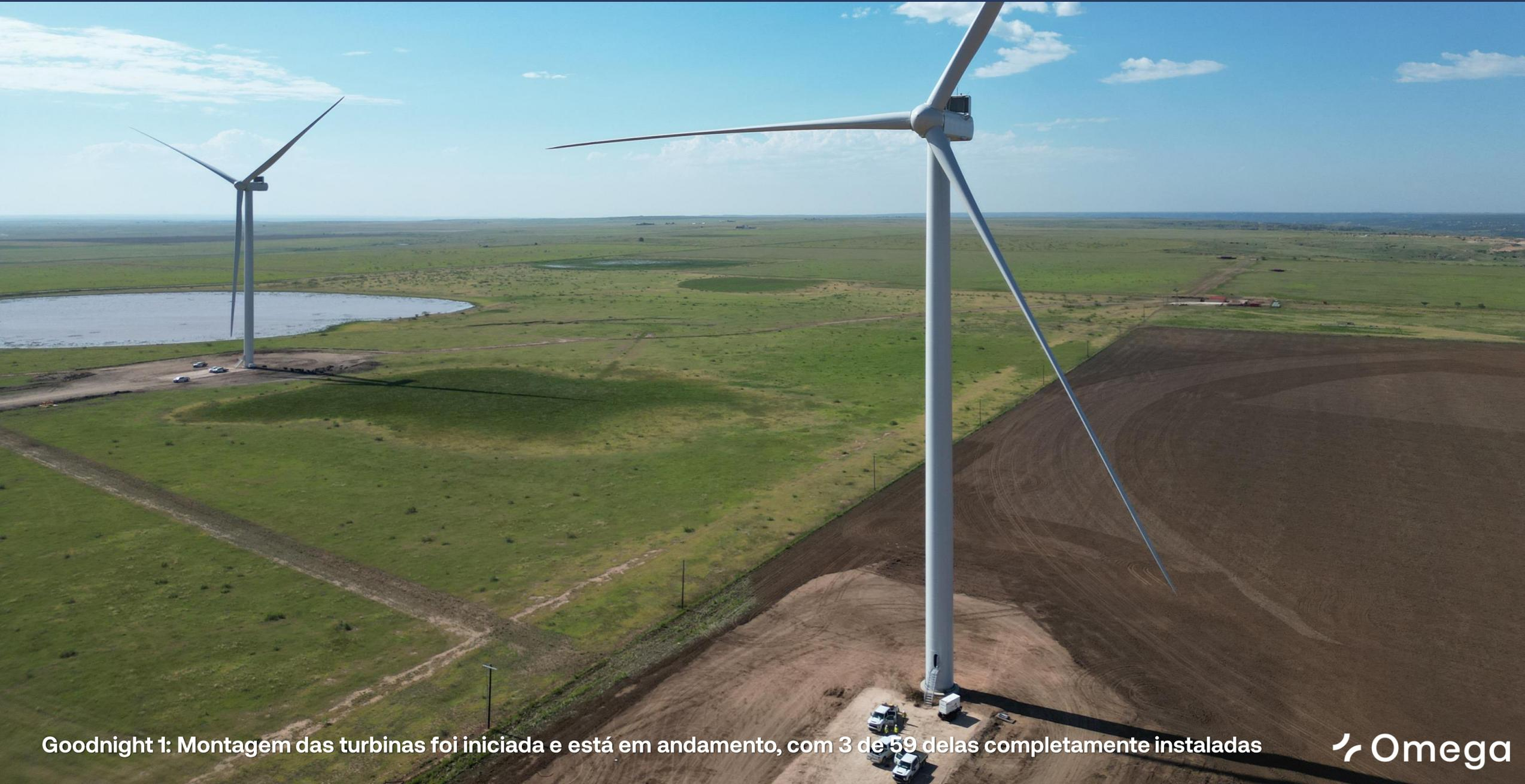
Goodnight 1: Montagem das turbinas foi iniciada e está em andamento, com 3 de 59 delas completamente instaladas
