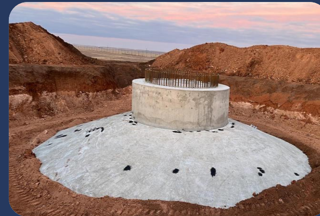
Last WTG foundation ready to be pour
