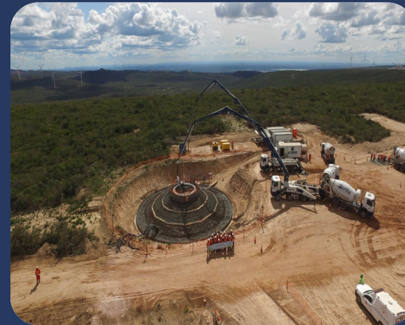
Fundação Turbina Assuruá 4
