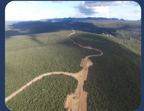
Estradas Obras Civas Assuruá 5
