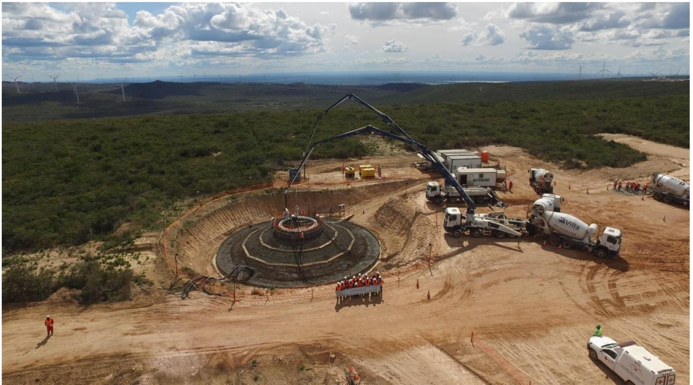
Fundação Turbina Assuruá 4 (total de 47): 14 concretadas e 6 reaterradas
