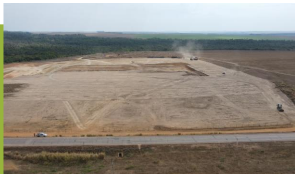
Obras em Andamento
