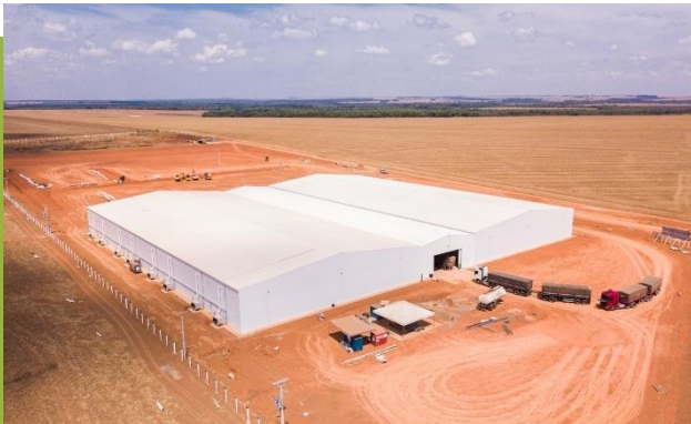
Conclusão das obras
