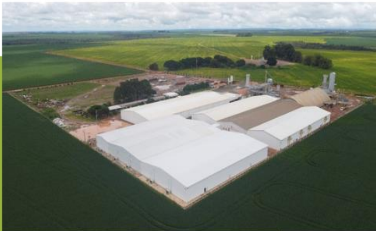
Conclusão das obras
