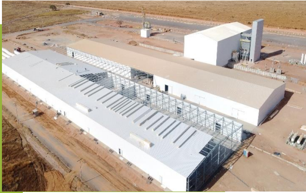
Finalização das obras
