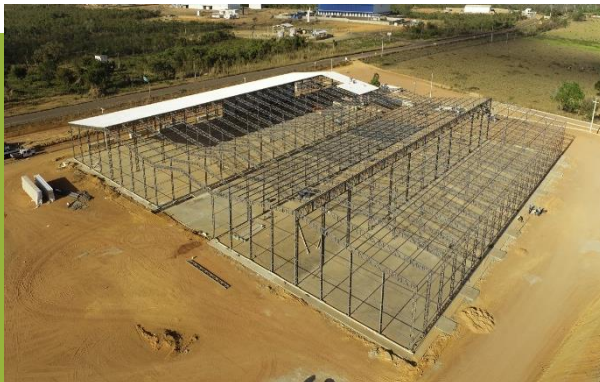
Obras em Andamento
