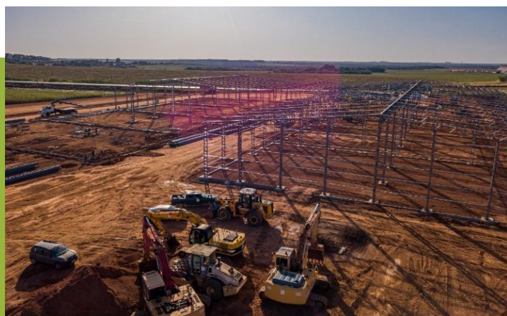
Início das obras
