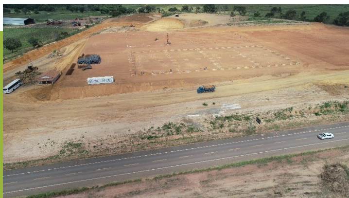
Início das obras
