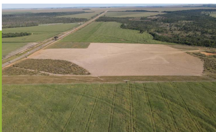
Início das obras
