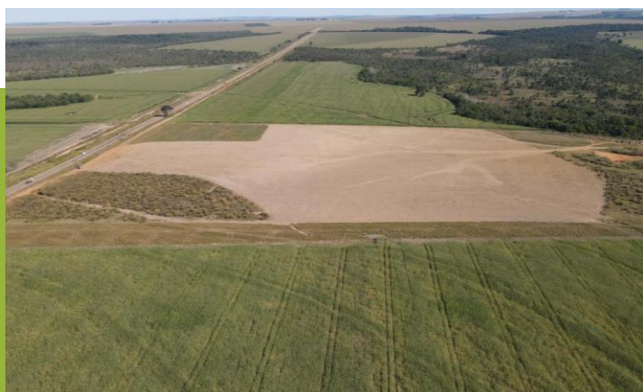
Início das obras
