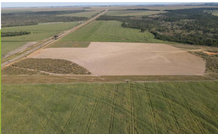
Início das obras
