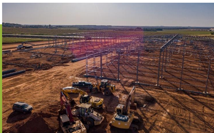
Início das obras
