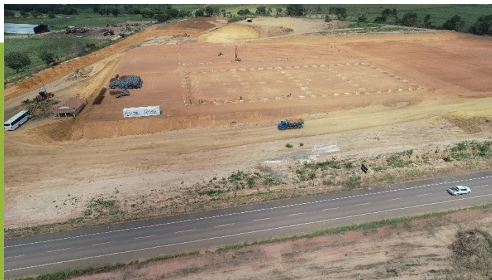
Início das obras
