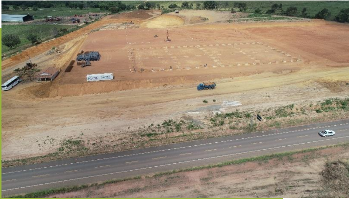
Início das obras
