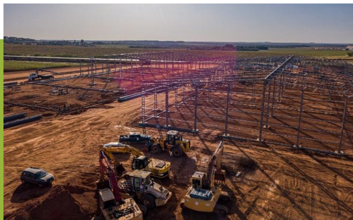
Início das obras
