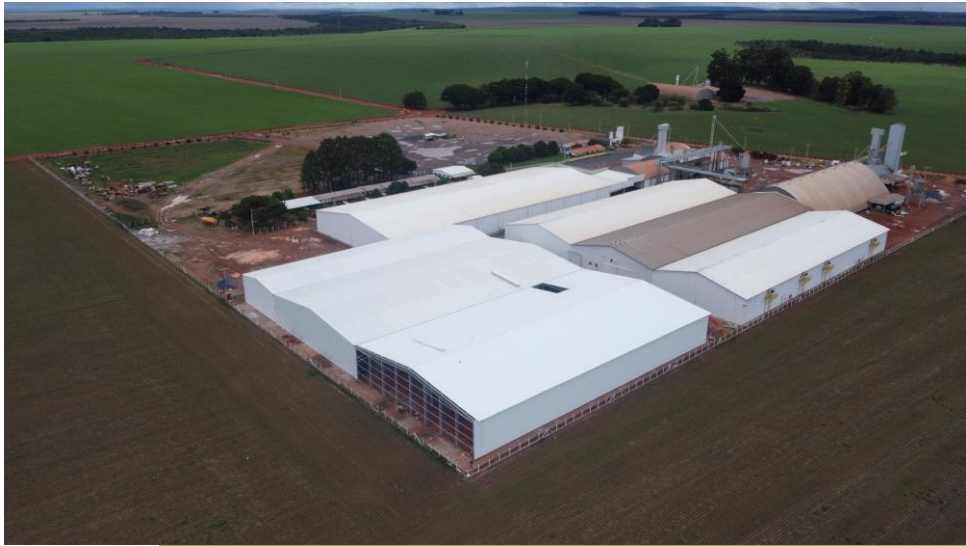
Obra em andamento / fase de finalização
