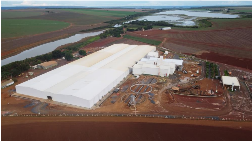
Obra em andamento / fase de finalização
