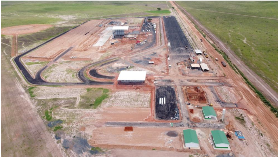
Obra em andamento
