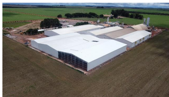
Obra em andamento / fase de finalização
