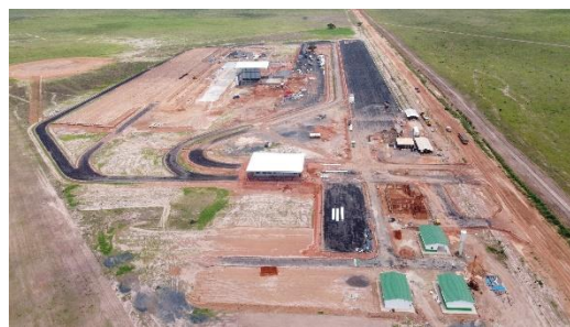
Obra em andamento
