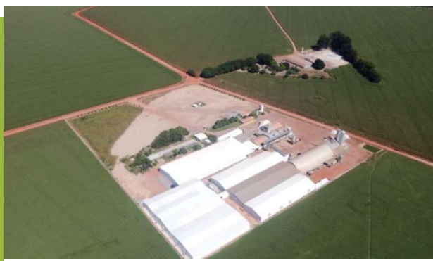
Obras de ampliação em andamento
