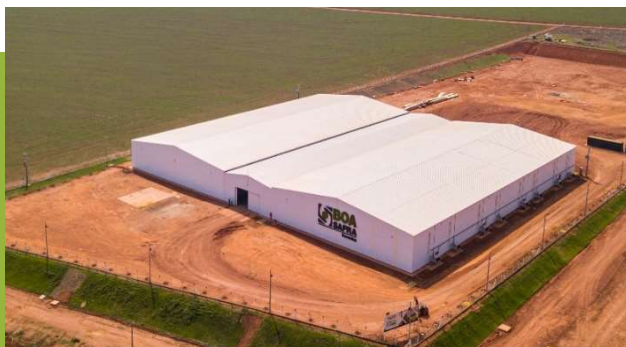
Obras de ampliação em andamento
