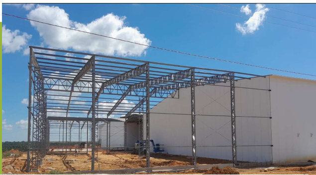
Obras de ampliação em andamento
