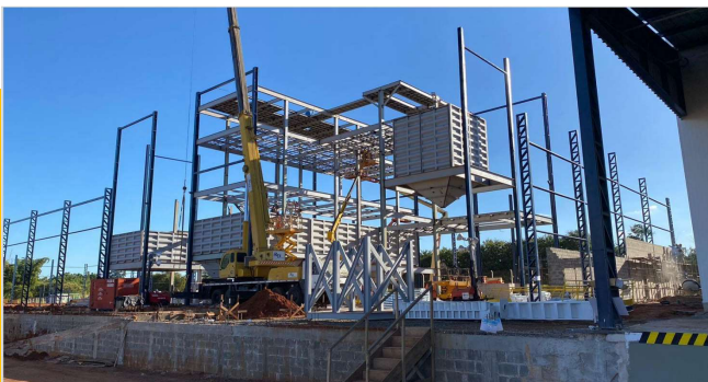
Obras de ampliação em andamento
