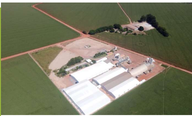
Obras de ampliação em andamento
