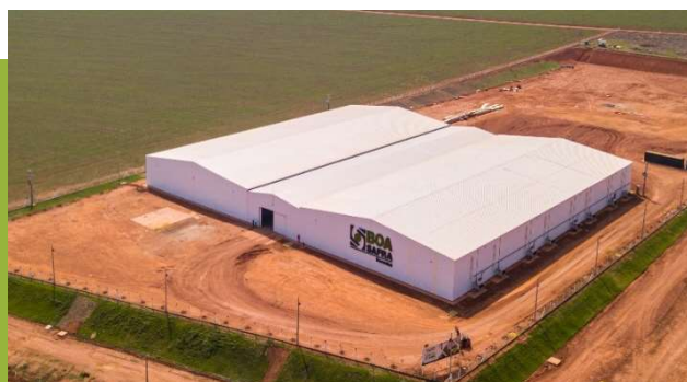
Obras de ampliação em andamento
