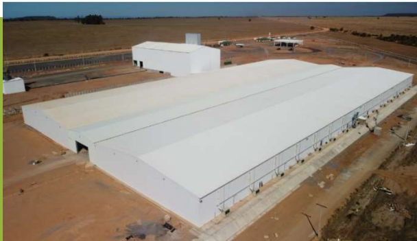
Obras de ampliação em andamento
