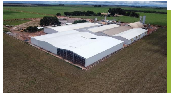
Obra em andamento / fase de finalização
