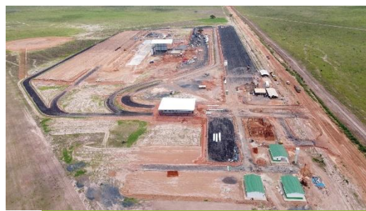
Obra em andamento
