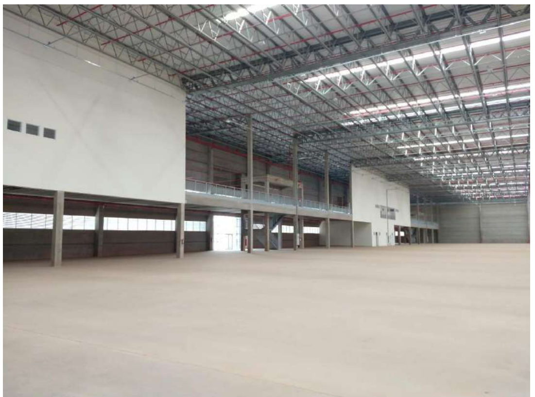
VISTA INTERNA DO GALPÃO E MEZANINO
