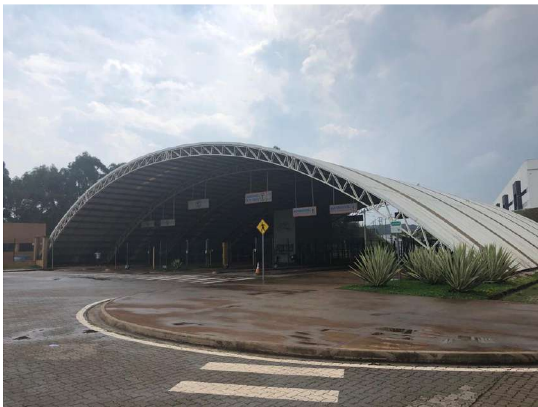
PORTARIA DO CONDOMÍNIO
