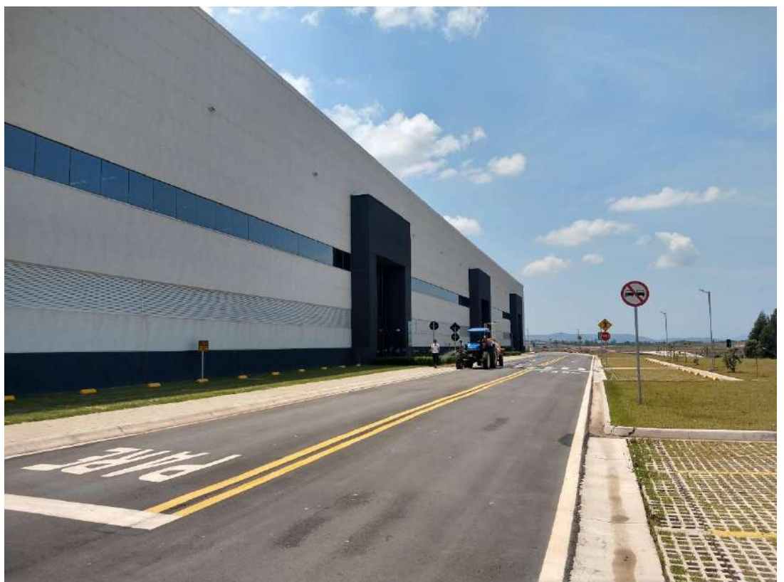
FACHADA DO IMÓVEL E ÁREA DE CIRCULAÇÃO
