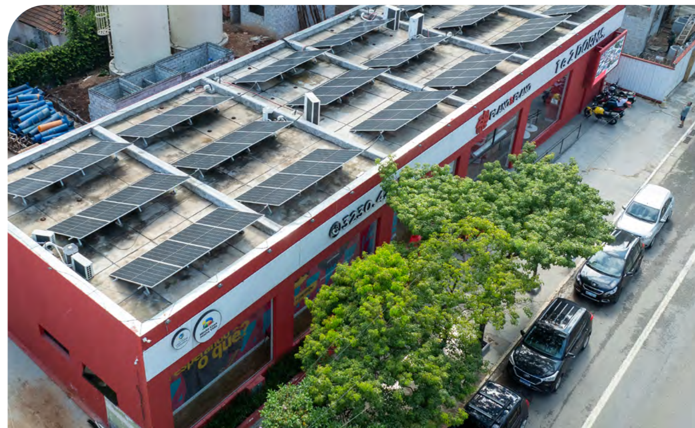
Instalação de painéis solares no Stand de Vendas do empreendimento Portal Vila Prudente, gerando energia fotovoltaica para consumo dos canteiros de obras
