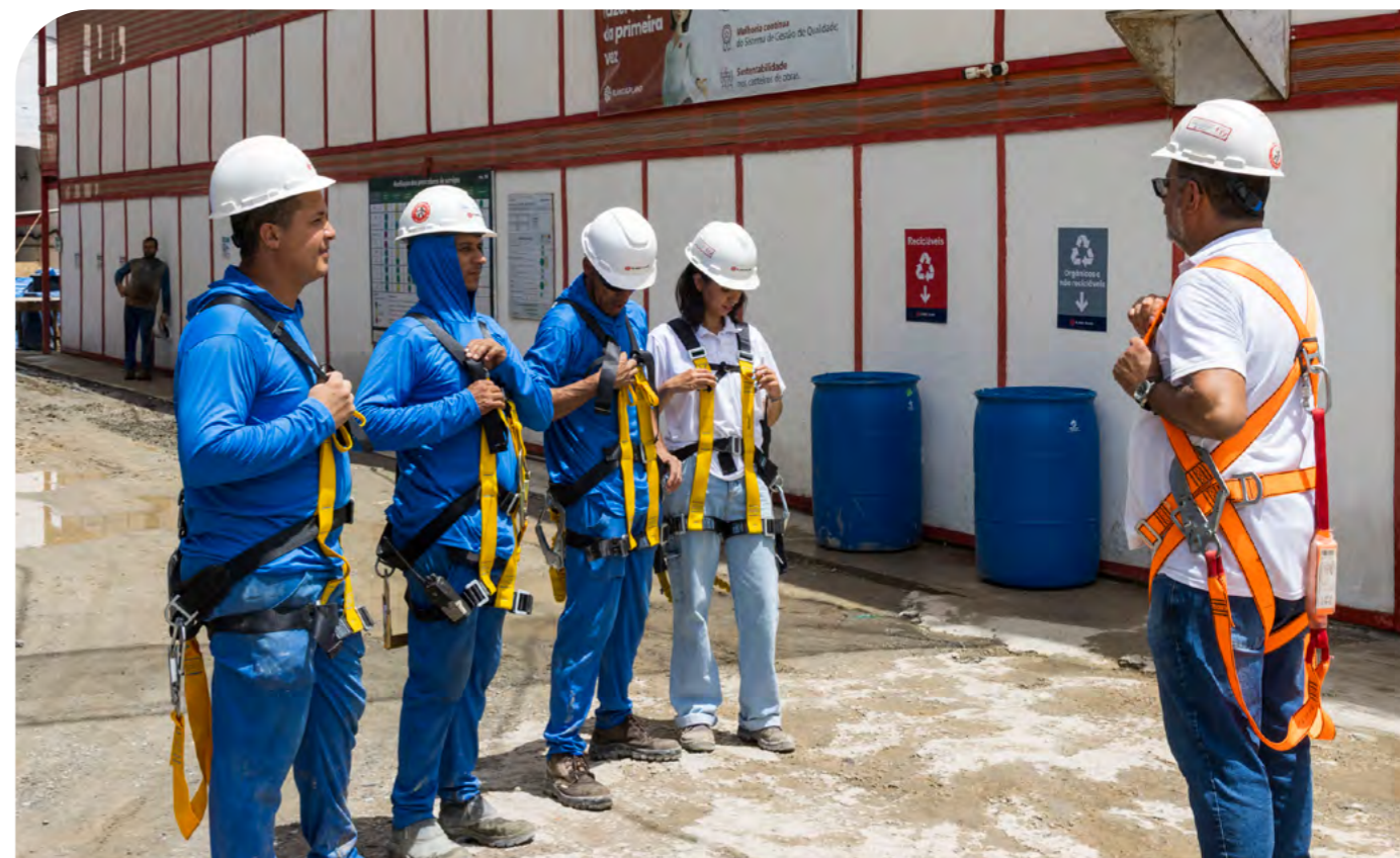
Treinamento de Segurança do Trabalho na obra
