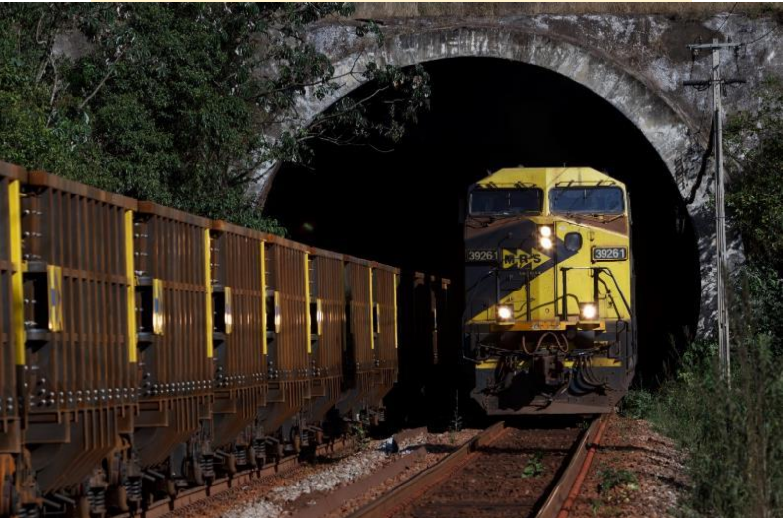
Trem da MRS túnel ferroviário
