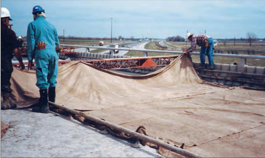
FIGURA 7.11B. Curando o tabuleiro de ponte de concreto de sílica ativa. Aplicar serapilheira úmida enquanto o concreto ainda estiver muito macio para ser pisado.
