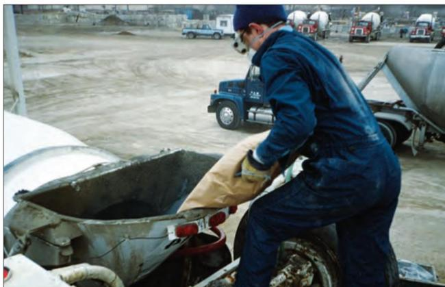
FIGURA 6.8. Esvaziando um saco de sílica ativa densificada em uma betoneira.
