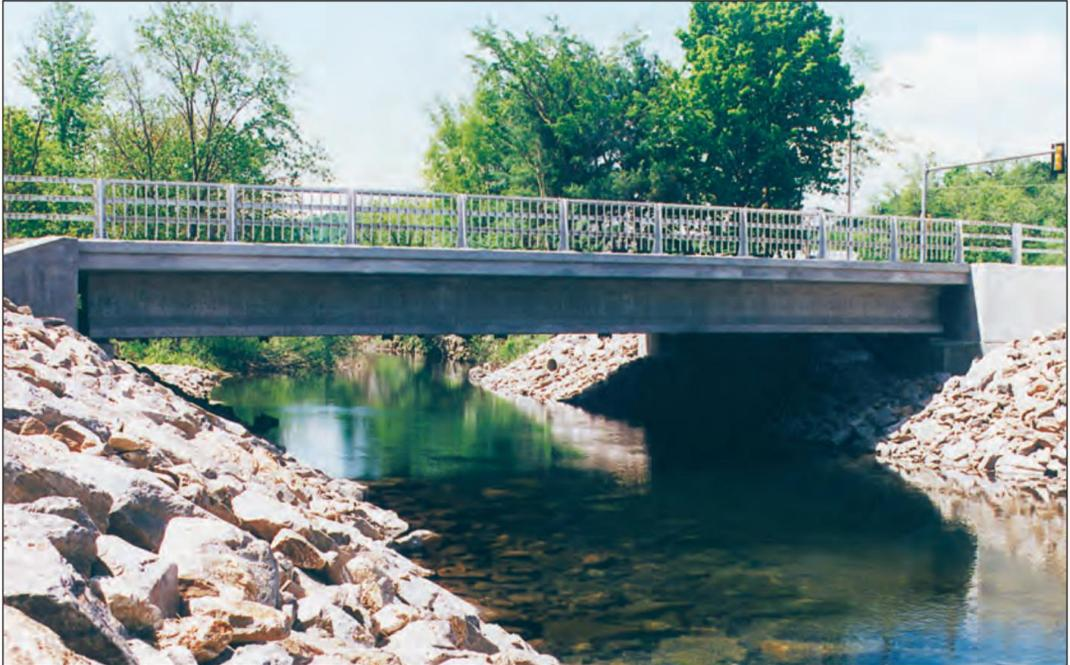
**FIGURA 3.8.** Ponte de concreto de alto desempenho. Nesta ponte em New Hampshire, o concreto de alta resistência foi usado para reduzir o número de vigas necessárias para a estrutura. Para mais informações sobre esta ponte, ver o artigo de Wasczik (1999).
