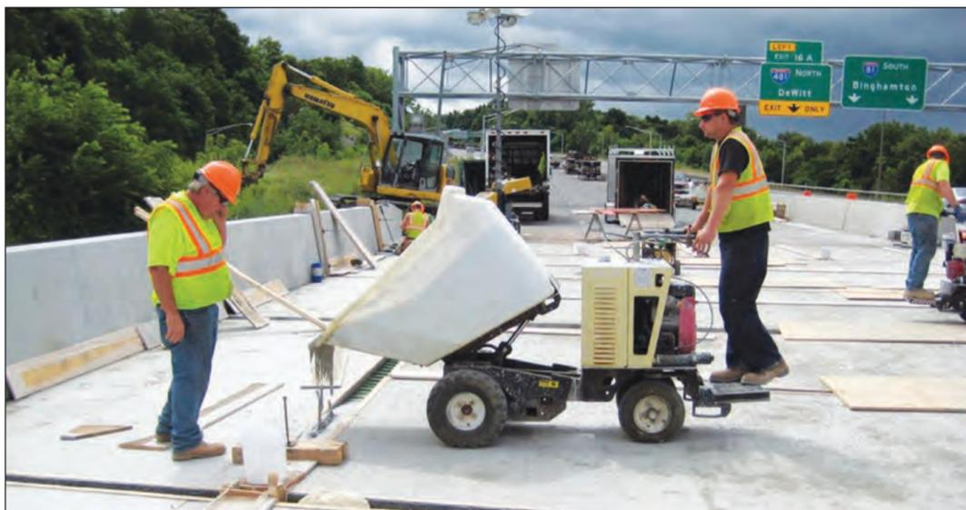
FIGURA 3.23. Colocação de UHPC entre painéis de convés pré-moldados adjacentes. (FHWA 2019)
