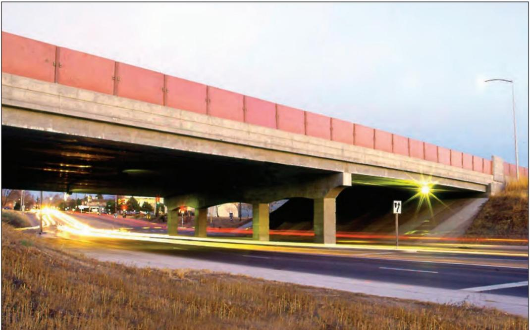
**FIGURA 3.9.** Ponte de concreto de alto desempenho. Nesta ponte no Colorado, o concreto de alta resistência foi usado para aumentar o comprimento do vão para eliminar dois pilares e aumentar a folga sob a ponte. Para mais informações sobre esta ponte, ver o artigo de Leonard (1999).
