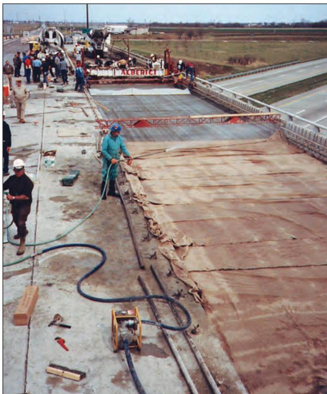
FIGURA 7.11A. Curando o deck da ponte de sílica ativa. A cura é seguir a colocação e o acabamento sem demora.
