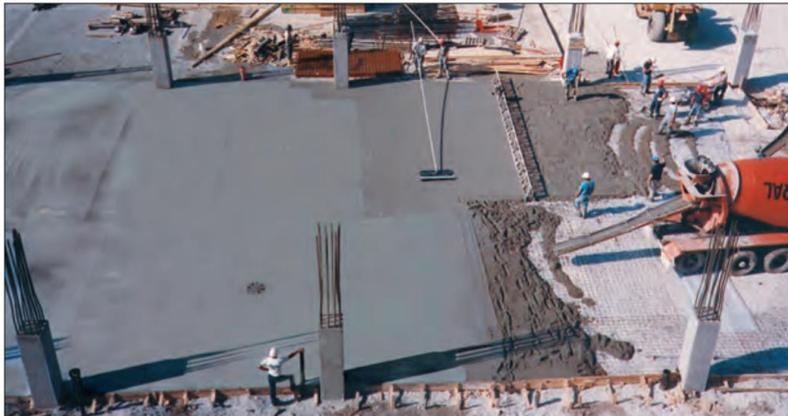
FIGURA 7.12. Acabamento em uma passada. O concreto está sendo colocado, nivelado, flutuado, texturizado e curado sem qualquer espera entre as operações.
