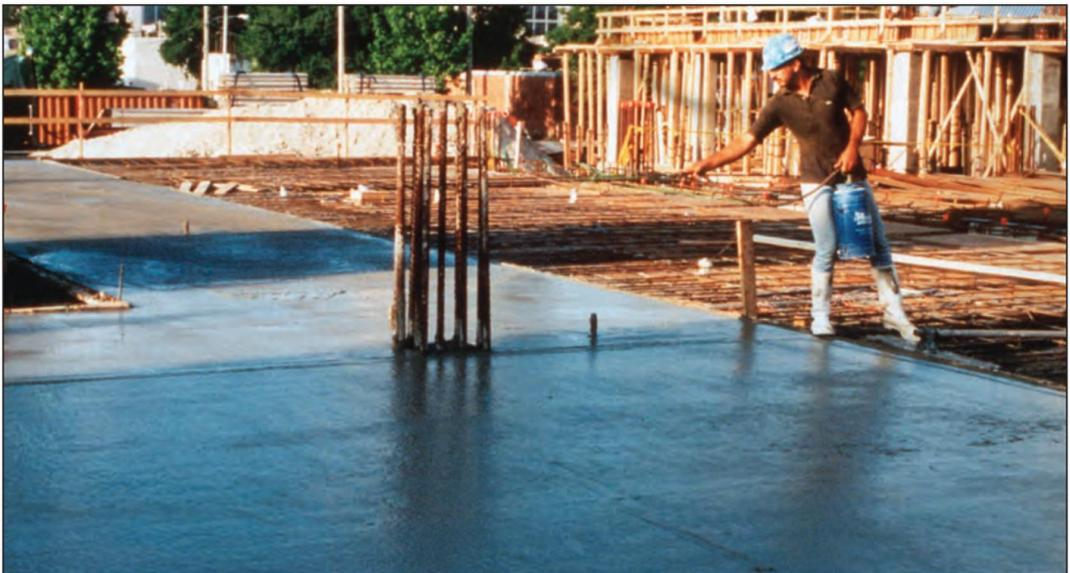
FIGURA 7.4. Aplicação de retardador de evaporação ao concreto de sílica ativa para evitar a perda de umidade antes do início da cura.
