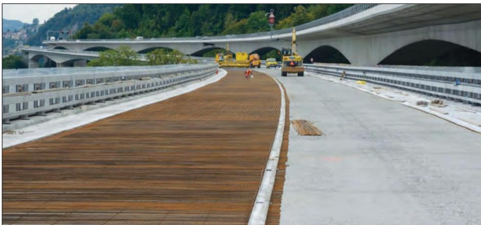
FIGURA 3.24A. Plataforma do Viaduto Chillon preparada para revestimento com concreto UHPC.
