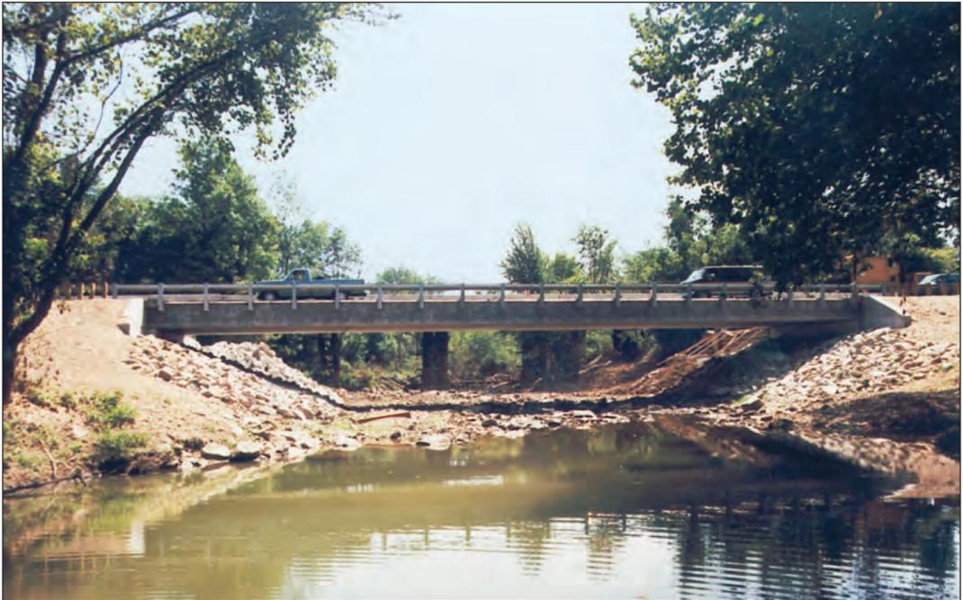
**FIGURA 3.7.** Ponte de concreto de alto desempenho. Nesta ponte em Ohio, o concreto de alta resistência foi usado para aumentar o comprimento do vão e eliminar um píer no rio. Para mais informações sobre esta ponte, ver o artigo de Miller (1999).
