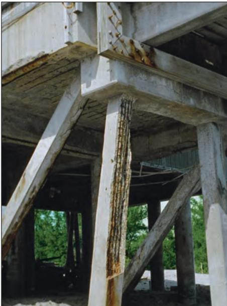
FIGURA 3.12. Danos por corrosão a uma estrutura marítima.
