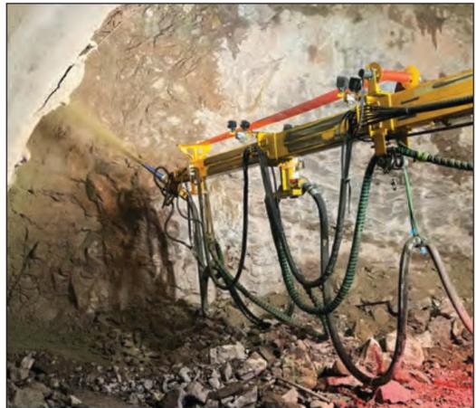
**FIGURA 3.20B.** Aplicação robótica de concreto projetado de sílica ativa para sustentação do solo. Este processo é usado com e sem fibras de aço para desempenho de flexão adicional.
