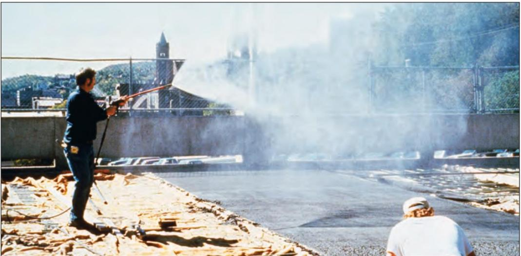
FIGURA 7.5A. Nebulização adequada do concreto de sílica ativa em uma estrutura de estacionamento para aumentar a umidade e evitar a secagem da superfície do concreto.
