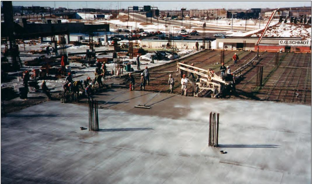
FIGURA 3.3. Acabamento em um passe de concreto de sílica ativa em uma estrutura de estacionamento. Colocação, acabamento, texturização e cura são feitos como um processo contínuo.
