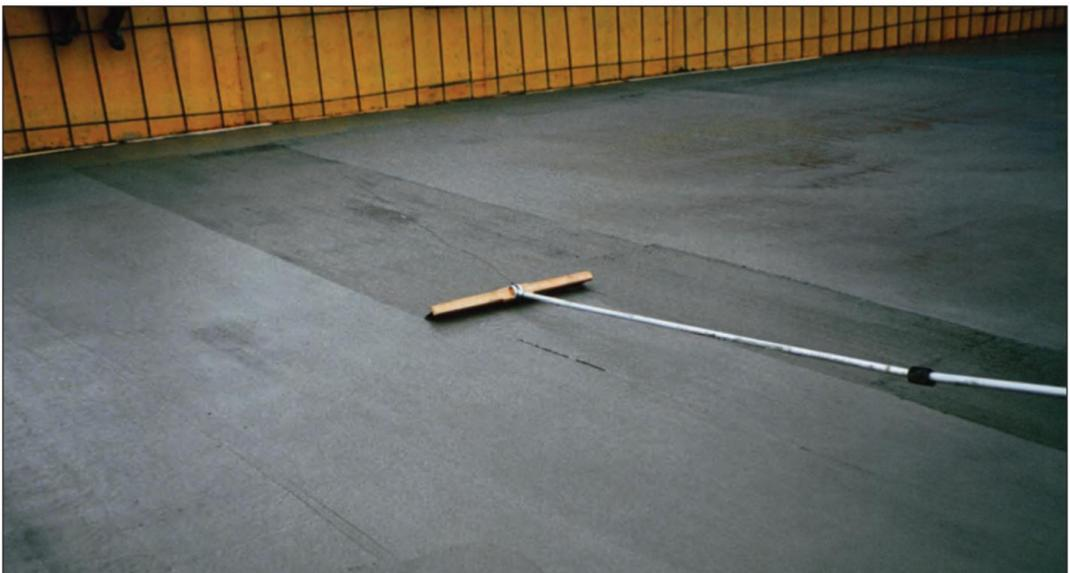
**FIGURA 7.17C.** Limpeza de uma superfície de concreto de sílica ativa. Nesse caso, a vassoura tem um fio preso a ela para levantá-la da superfície e movimentá-la da direita para a esquerda na foto. A textura é aplicada puxando a vassoura da esquerda para a direita.
