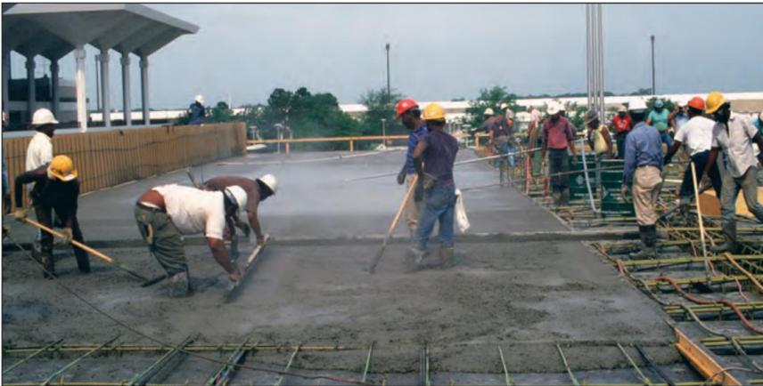
FIGURA 7.15A. Consolidação de concreto de sílica ativa com mesa manual.
