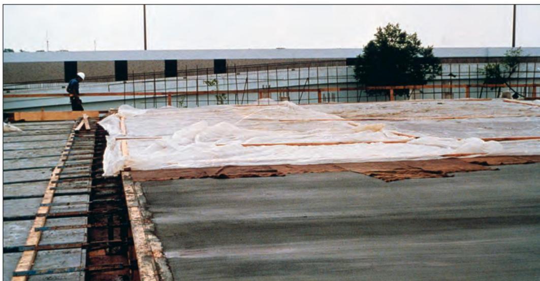
FIGURA 7.19. Serapilheira e folhas de plástico usadas para a cura final. Para a maioria das aplicações de concreto de sílica ativa, a cura úmida fornecerá melhor qualidade do concreto no local do que o uso de um composto de cura sozinho.
