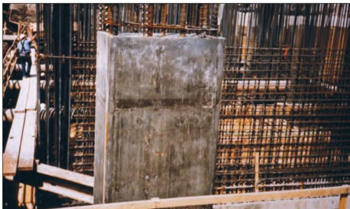
FIGURA 3.6. Coluna de concreto de sílica ativa de alta resistência em estrutura de grande altura.
