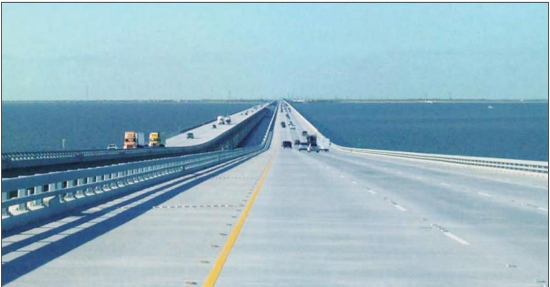
**FIGURA 3.15.** Depois que o furacão Katrina danificou a rodovia I-10 em Nova Orleans, o Departamento de Transporte da Louisiana projetou sua substituição para uma vida útil mais longa com maior durabilidade do concreto, especificando uma taxa de permeabilidade rápida de cloreto muito baixa em sua nova estrutura de concreto.
