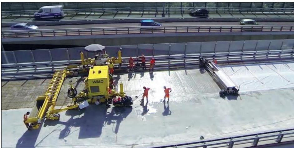
FIGURA 3.24B. UHPC sendo colocado. Observe o processo de cura imediatamente após a colocação.
