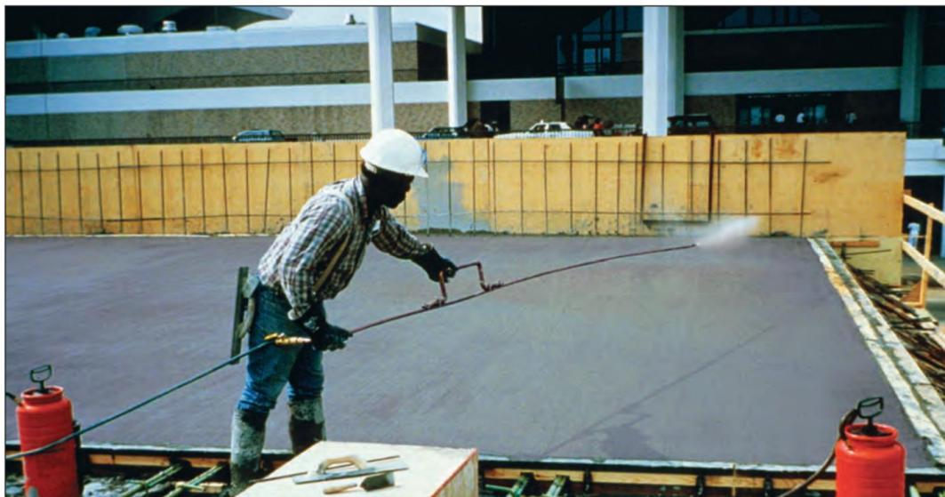
FIGURA 7.18. O composto de cura está sendo aplicado ao concreto de sílica ativa em uma estrutura de estacionamento logo após a limpeza. Em muitos casos, o uso de composto de cura é o método de cura preliminar; destina-se a proteger o concreto até que ganhe resistência suficiente para permitir a colocação de materiais de cura úmida no tabuleiro sem danificar a superfície. Neste projeto específico, estopa úmida e folhas de plástico foram usadas para a cura final.
