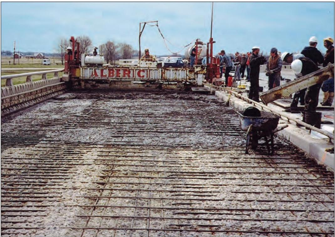
**FIGURA 7.7.** Plataforma de ponte de concreto preparada para uma cobertura de concreto de sílica ativa. O concreto deteriorado foi removido e o aço de reforço foi limpo para preparar a colocação da cobertura.
