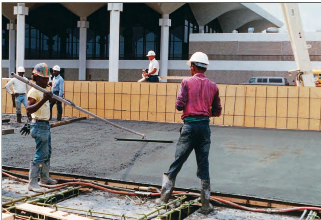
FIGURA 7.16. Após a pavimentação, a próxima etapa de acabamento é fazer o bote flutuante do concreto. A boia flutuante nivela a superfície e prepara o concreto para receber a textura desejada.
