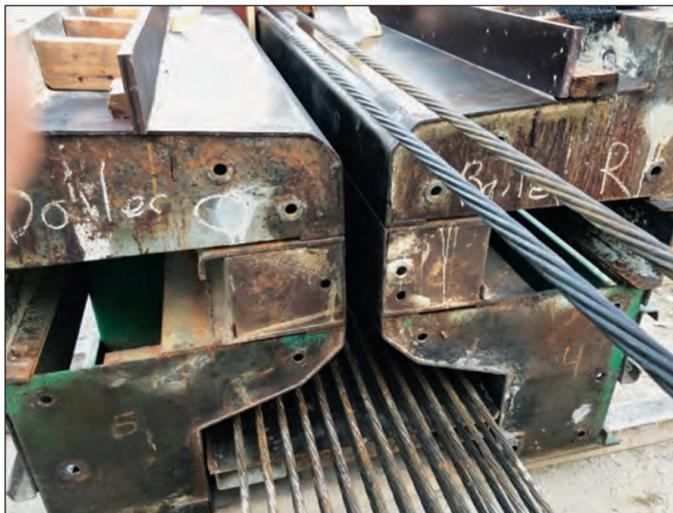
FIGURA 3.25A. Seção transversal de uma viga pronta para receber UHPC. Observe o volume de concreto minimizado e ausência de aço de reforço secundário.
