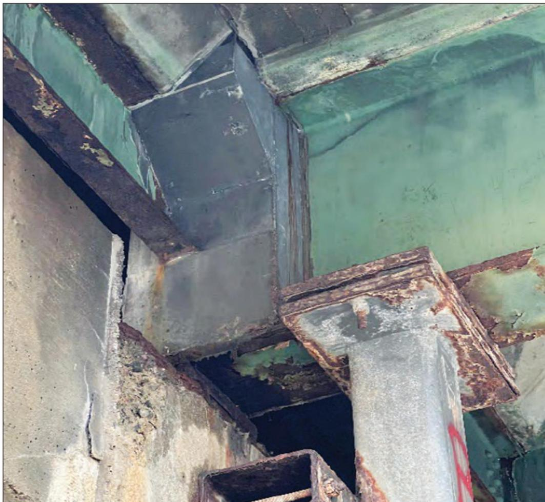
FIGURA 3.22. Fim da viga da ponte de aço após reparo usando UHPC. (FHWA 2022)
