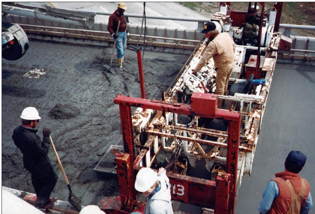
FIGURA 7.9. Máquina de tabuleiro de ponte sendo usada para colocar revestimento de concreto de sílica ativa.
