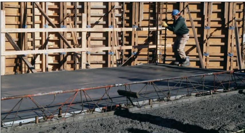
FIGURA 7.15B. Consolidação de concreto de sílica ativa usando uma mesa treliçada vibratória.
