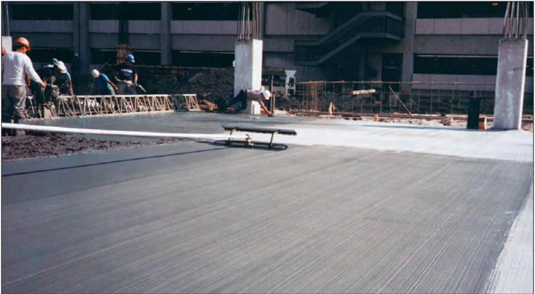
**FIGURA 7.17B.** Esta foto mostra uma ferramenta de acabamento que é uma combinação de flutuador e vassoura. Em uma direção, serve como um flutuador. Na outra direção, serve de vassoura.
