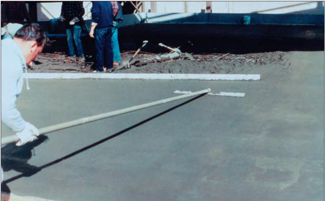
**FIGURA 7.17A.** Dependendo da natureza do acabamento superficial selecionado, pode ser necessário realizar uma passada adicional com float antes da aplicação da textura superficial.
