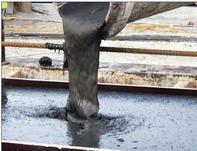
FIGURA 3.25B. A mesma viga sendo "rematada". Colocado a partir de um único ponto, as características de alto fluxo do UHPC permitem o preenchimento lateral sem vazios de maneira monolítica.
