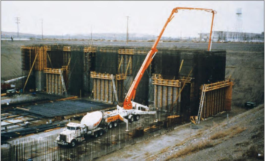
**FIGURA 3.18.** Concreto contendo cimento portland, cinzas volantes e sílica ativa sendo colocado. As cinzas volantes foram usadas para controlar o calor de hidratação, enquanto a sílica ativa forneceu resistência inicial necessária para formas de decapagem. Para mais informações sobre este projeto, ver o artigo de Holland (1998).
