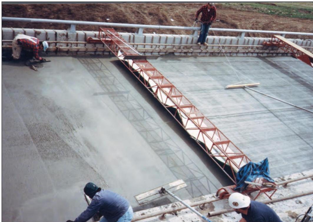
**FIGURA 7.10A.** Aplicando um acabamento escovado. Após a máquina de acabamento passar sobre a superfície, pode ser necessário algum acabamento manual adicional, particularmente ao longo das bordas da colocação. A texturização com vassoura também pode ser vista nesta foto.
