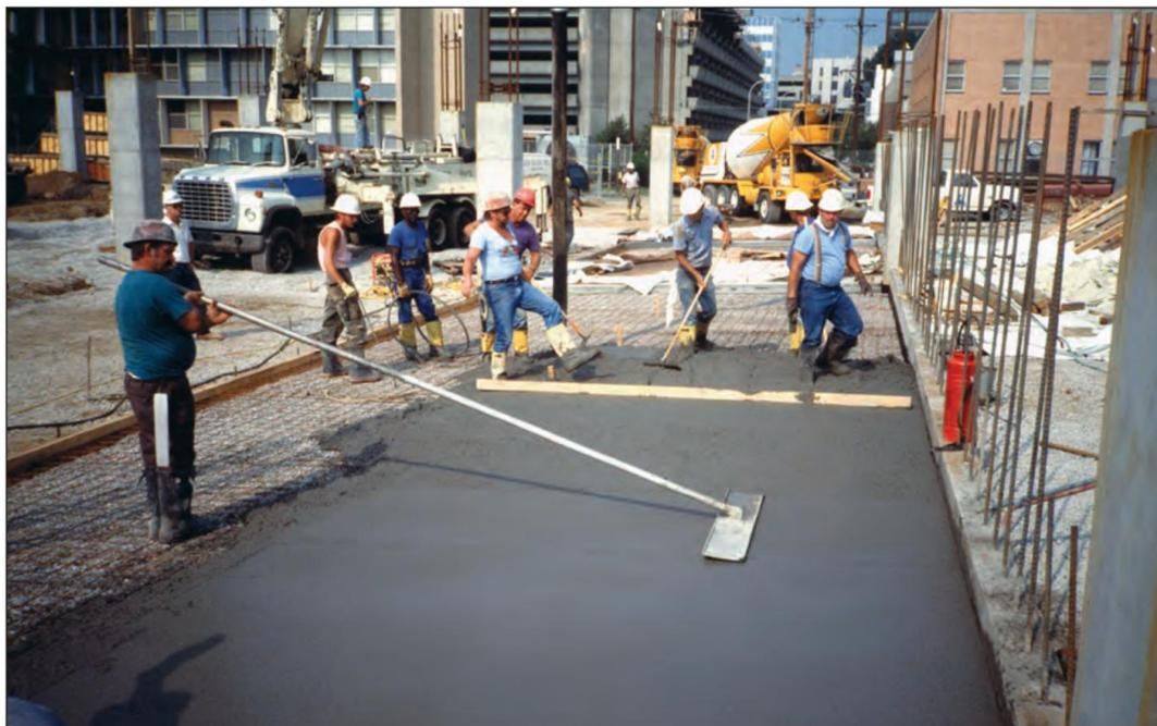
**FIGURA 7.14.** Realização de uma colocação experimental usando o processo de acabamento em uma etapa usando uma laje no solo na estrutura real. Observe que colocar a tela de arame na parte inferior da laje não é uma prática recomendada.
