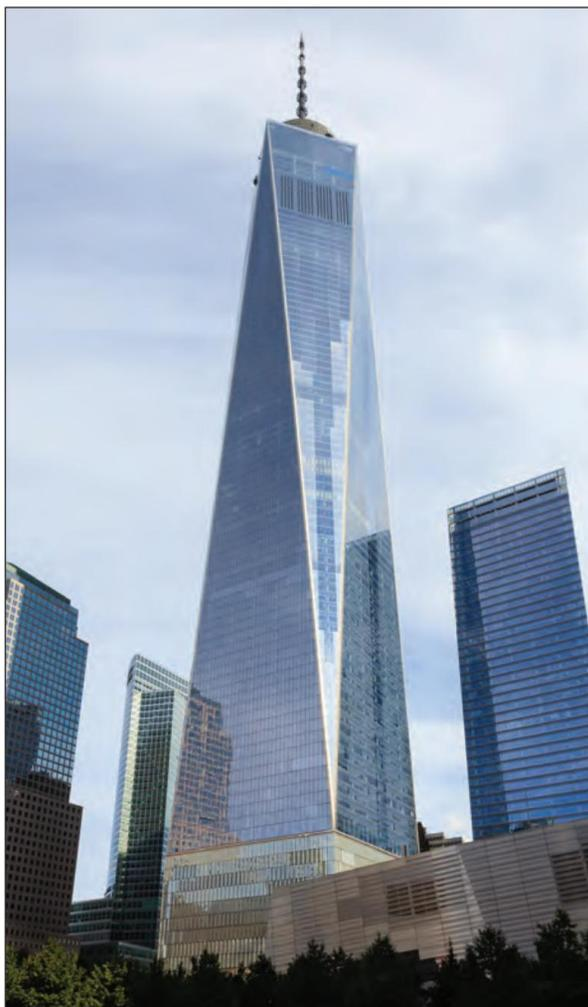
FIGURA 3.19. Para o World Trade Center, a alta resistência foi inicialmente o principal objetivo das propriedades do concreto endurecido. A capacidade de atingir a capacidade de bombeamento de longa distância, vertical e de estágio único do SCC, juntamente com a consolidação em torno do reforço congestionado, foi, em última análise, um objetivo mais importante no estado fresco desse concreto. Essa mistura de concreto também se destacou por sua pegada de baixo carbono.
