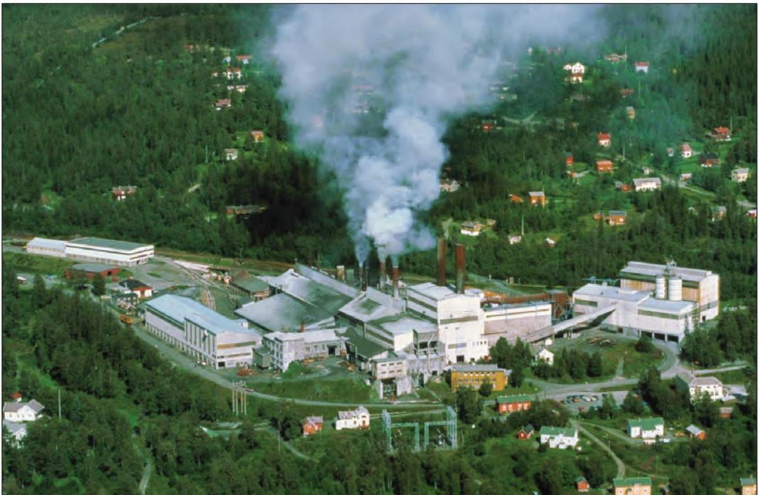
**FIGURA 1.2.** Fundição antes da instalação do equipamento para coleta de sílica ativa. A “fumaça” é fumaça de sílica sendo liberada para a atmosfera.
