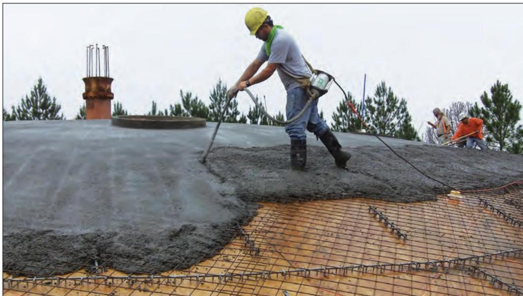
FIGURA 5.1. Concreto de sílica ativa sendo colocado na cúpula inclinada de um tanque de tratamento de águas residuais. Observe o concreto coesivo segurando o talude durante a vibração.
