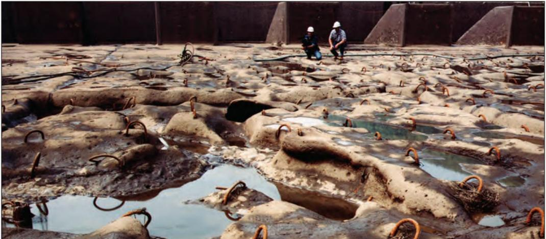
**FIGURA 3.17.** Concreto danificado por abrasão-erosão. Essa estrutura foi reparada com concreto de sílica ativa de alta resistência com resistência à compressão especificada de 86 MPa. Para mais informações sobre este projeto, veja o artigo de Holland et al. (1986).
