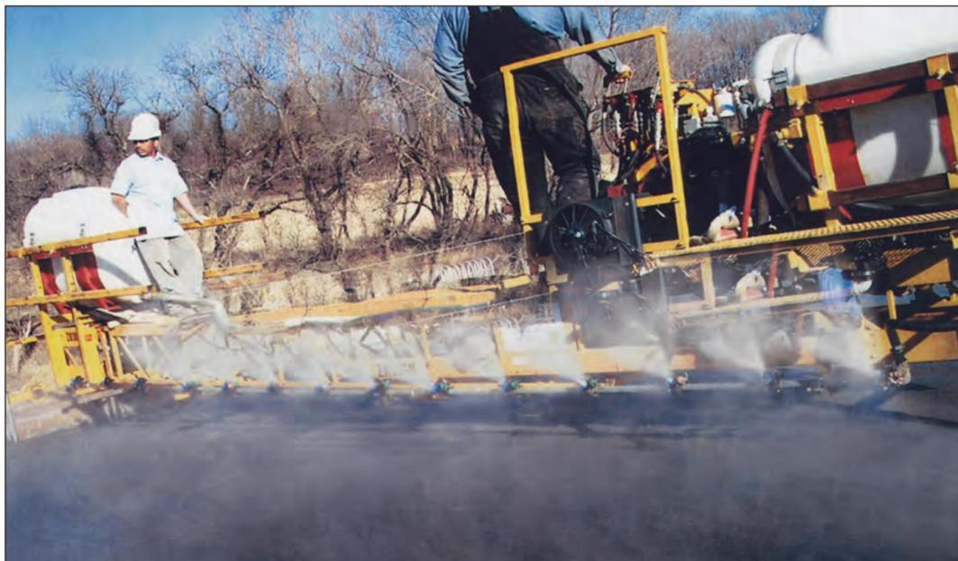
FIGURA 7.5B. Equipamento de nebulização montado em máquina de pavimentação. Os bicos de neblina são apontados para cima para que a umidade não seja adicionada à superfície do concreto.
