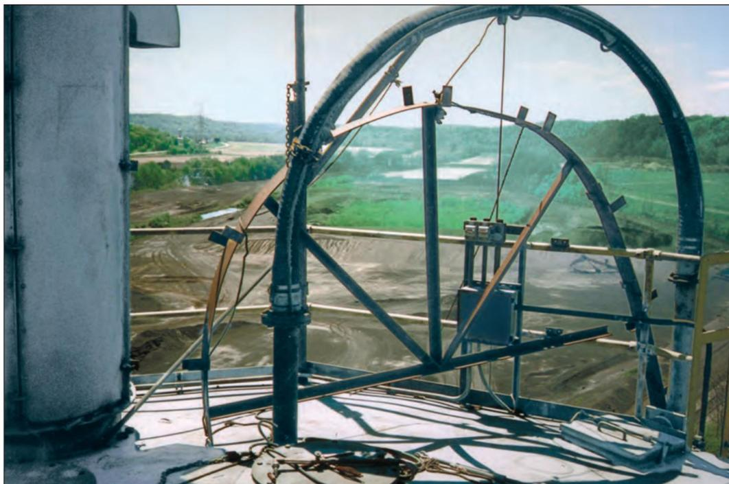
FIGURA 6.4C. Mangueira de enchimento de borracha conectada ao tubo de aço no topo do silo. Observe a estrutura de suporte para a fabricação da mangueira de borracha.
