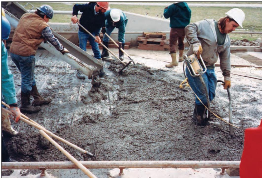
**FIGURA 7.8.** Concreto de sílica ativa sendo colocado no convés. Observe o uso do vibrador para proporcionar consolidação adicional àquela fornecida pela máquina de acabamento.
