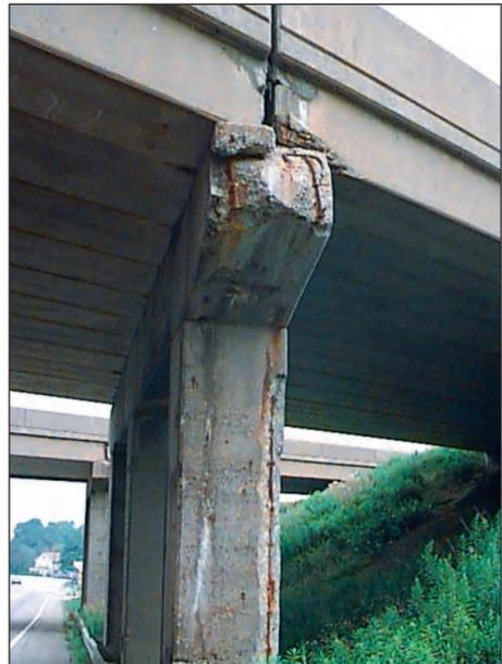
FIGURA 3.13. Danos por corrosão em um viaduto de rodovia. Observe que os cloretos aparentemente escorreram do convés para este píer. Os elementos estruturais, assim como os decks, devem ser protegidos.
