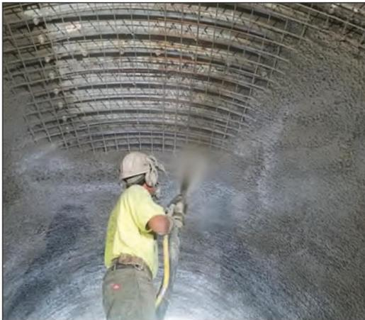
**FIGURA 3.20A.** Aplicação aérea de concreto projetado de sílica ativa. Por causa de sua maior coesão, o concreto projetado com sílica ativa tem muito menos rebote e permite maior espessura de elevação ao ser projetado acima do que o concreto projetado sem sílica ativa.
