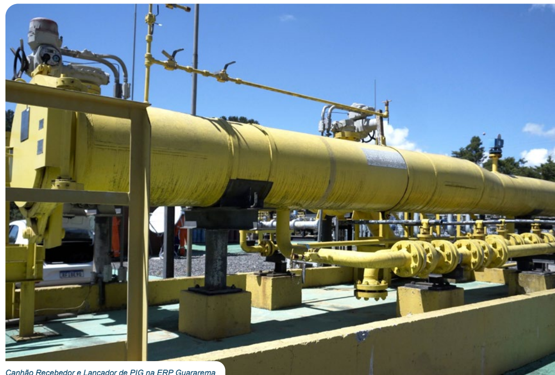
Canhão Recebedor e Lançador de PIG na ERP Guararema
