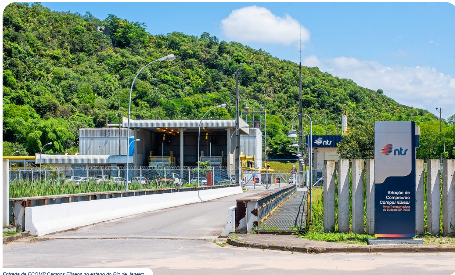
Entrada da ECOMP Campos Eliseos no estado do Rio de Janeiro
