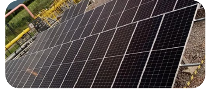
PR Itaboraí (RJ) 36 painéis de 470Wp Geração de energia em 2024: 2,55MWh (260 dias)
