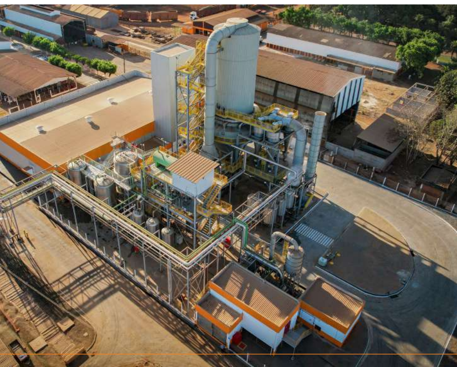
UISA BIONUTRITION, CONSTRUÇÃO CONCLUÍDA
