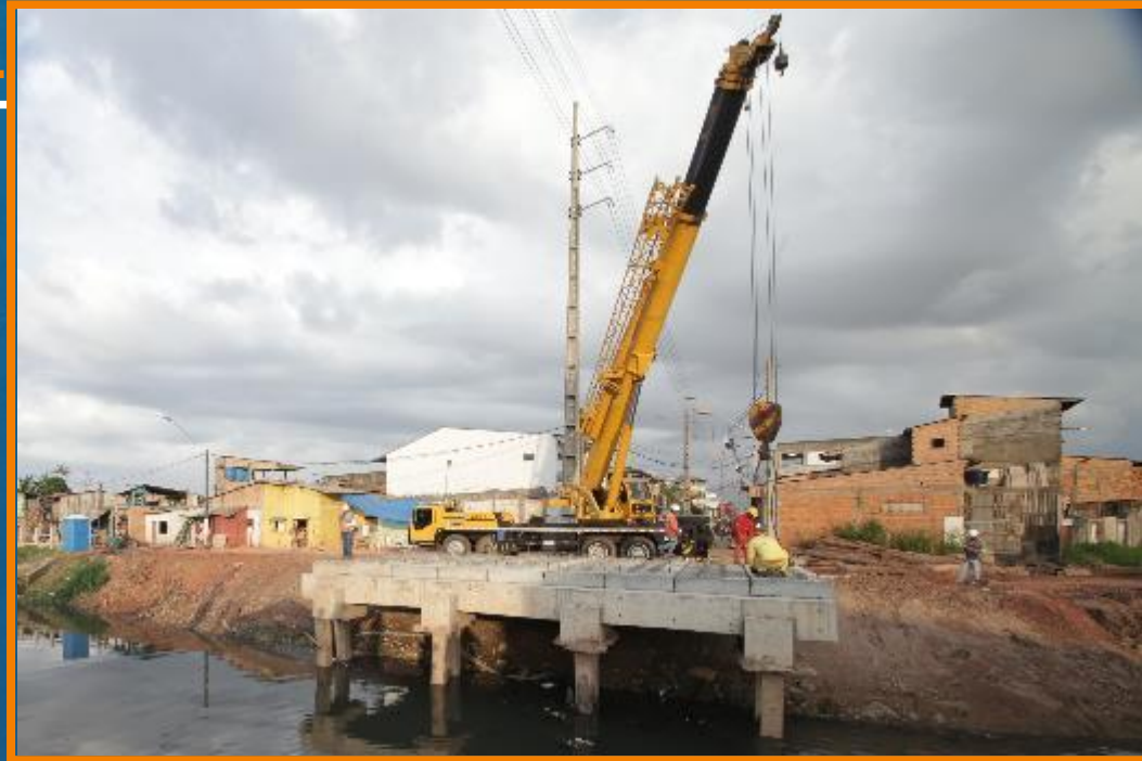
76º CAIXA Mais Brasil | 09 a 11 OUT 20 Obra da Bacia do Tucunduba – Belém/PA
