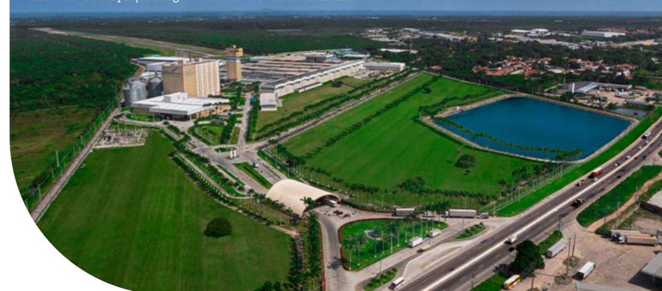
Reservatório de captação de água da chuva na Unidade Eusébio/CE
