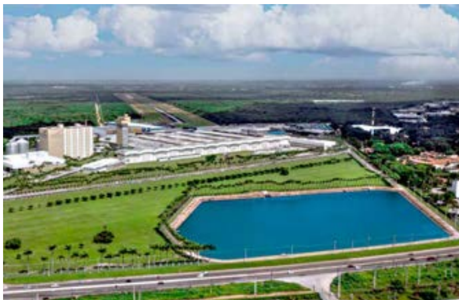
Unidade Eusébio/CE possui sistema de captação de água da chuva
