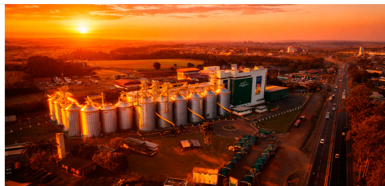
Unidade de moagem de trigo em Rolândia (PR)
