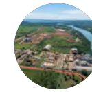
TSS - TERMINAL RODOFERROVIÁRIO (Parceria Caramuru + Rumo) EXPEDIÇÃO: 3.000 t/h CAPACIDADE DE ARMAZENAGEM: 42.000 t
