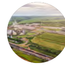
CARREGAMENTO FERROVIÁRIO EXPEDIÇÃO DE FARELO E SOJA: 500 t/h EXPEDIÇÃO DE BIODIESEL: 160 m³/h
