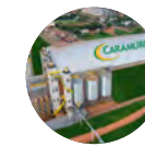
ARMAZENAGEM DE SOJA: 160.000 t
